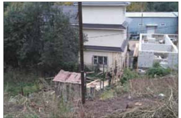
→ Строительство объекта на территории Спасского храма
