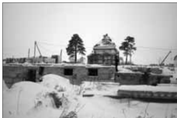
→ Возведен цокольный этаж архиерейского дома
