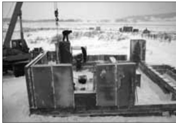
→ Возводятся основные конструкции малого келейного корпуса
