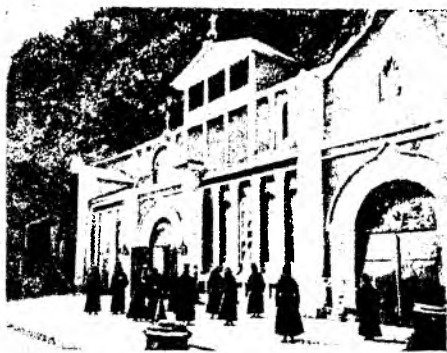
Впащніи пещеры и открытая галлерей къ дереву св. Николая въ Святогорской пустыни.
